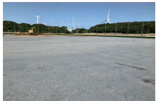
下層路盤工事中
