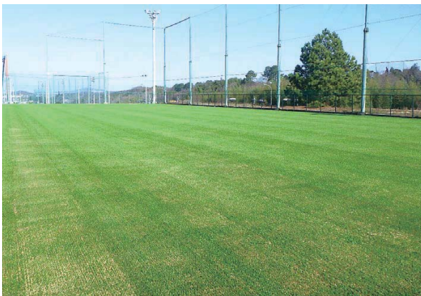
完成全景写真（養生中） 平成30年2月
