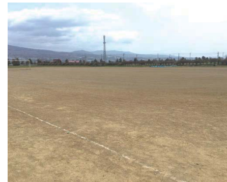
北海道 北斗市立大野中学校 ●施工 / 2014年11月 ●施工面積 / 5,050m 2 (撮影：2016年4月)
