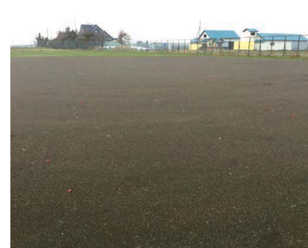
北海道空知郡 奈井江町立奈井江小学校 ●施工 / 2017年8月 ●施工面積 / 3,740m 2 (撮影：2017年10月)
