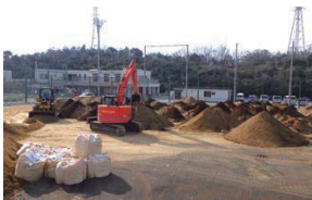
床土基盤改良（一次混合：改良材混合） 平成30年1月
