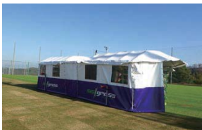
ハイブリッド化工事（人工芝繊維打込み） 平成30年2月
