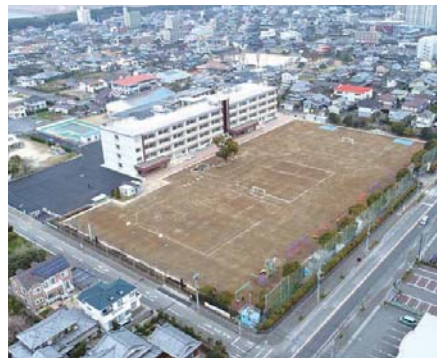
大分県 大分市立大在小学校 ●竣工 / 2017年3月 ●施工面積 / 10,740m 2 (撮影：2017年3月)
