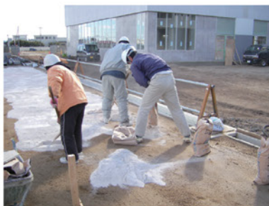
素地敷き均し
