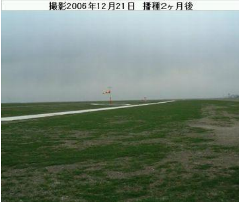
新北九州空港 本施工区経過写真
