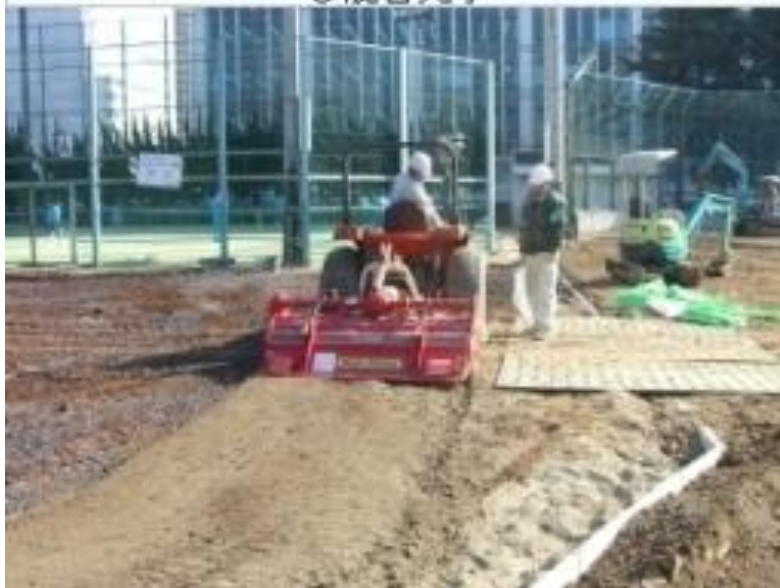
土壤改良施工状況
