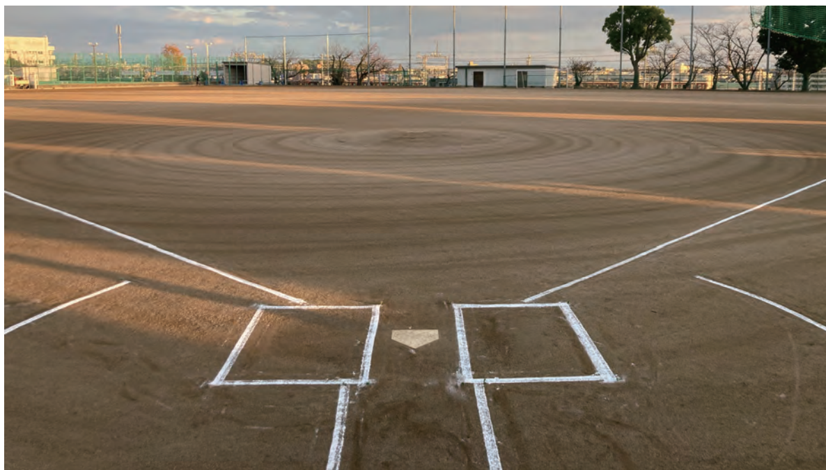
■施工面積：9,500㎡ ■施工：2020年8月 ■撮影：2020年11月
