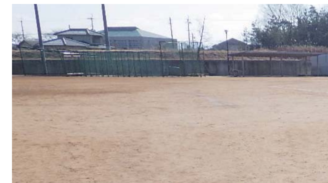
施工後 平成28年1月25日撮影
