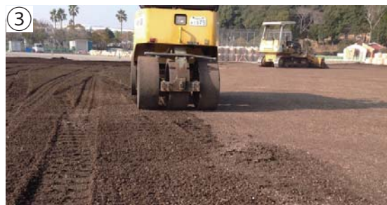
③ 転圧 平成27年1月10日撮影
