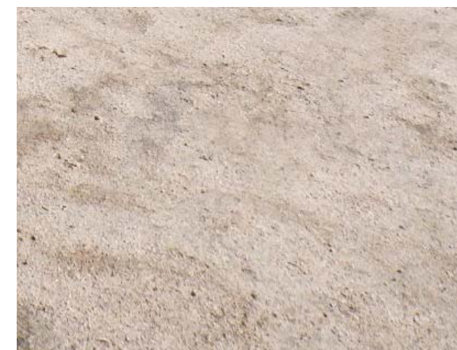
平成28年1月25日撮影 夜間最低気温-7.5℃ 改修後は、凍結・融解等によるぬかるみは無し
