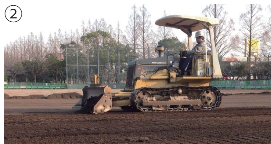
② 敷均し 平成27年1月10日撮影
