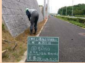
試験施工状況
